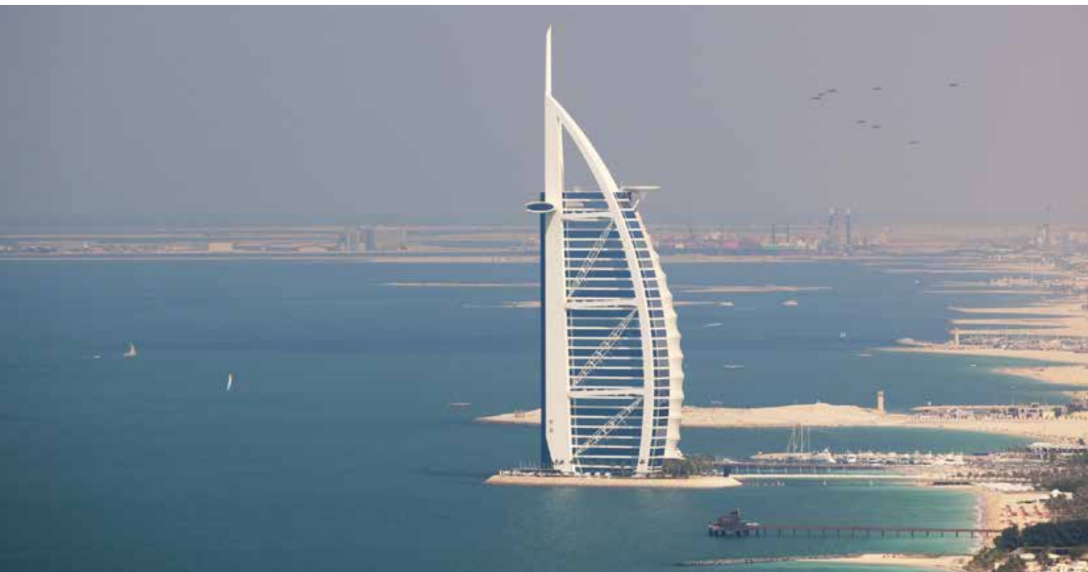
Burj Al Arab Jumeirah Beach Complex, Dubai, UAE Завершено в 1999 г. Thermalbond® V2200
