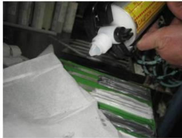
Этап 8 – кратковременно нажмите на спусковой механизм (над контейнером), пока обе части А и Б не начнут выходить из КТДЖ
